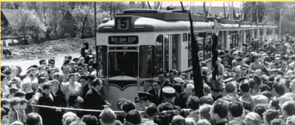
8. Mai 1960, der 1. Streckenabschnitt in „Regelspur“ (1435 mm Spurweite) geht zwischen Altchemnitz und Uhlestraße in Betrieb
