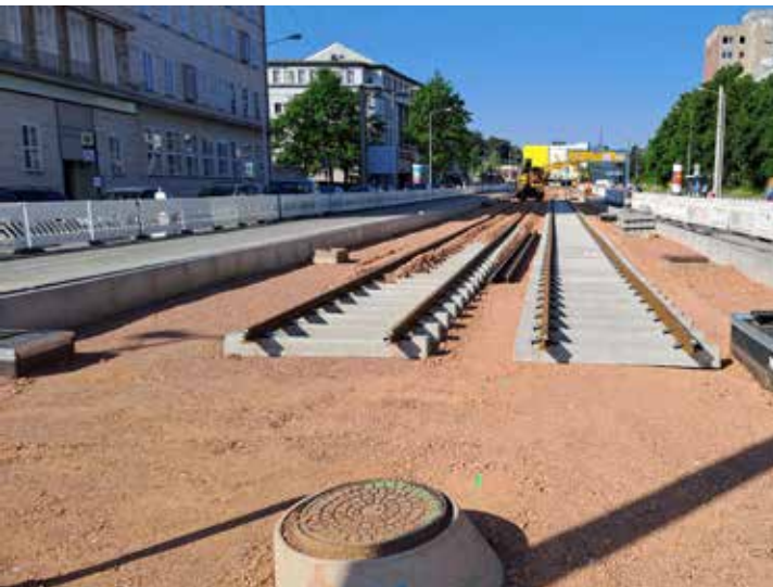
VERLEGUNG DER NEUEN GLEISE IM TEILABSCHNITT FALKEPLATZ – REICHSSTRASSE.
